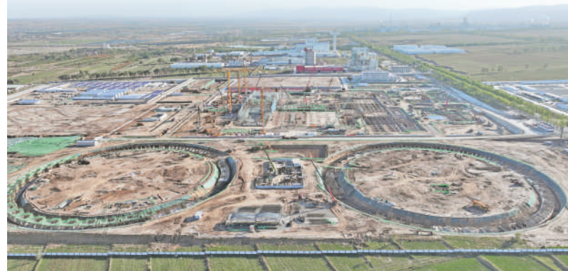
国能宁夏六盘山电厂2×1000兆瓦机组建设现场。
