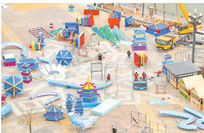
花灯组装现场。
