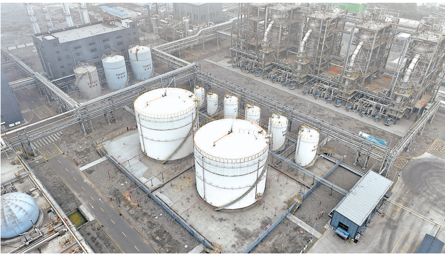
宁夏滨泽新能源科技有限公司厂区工业尾气发酵装置。
