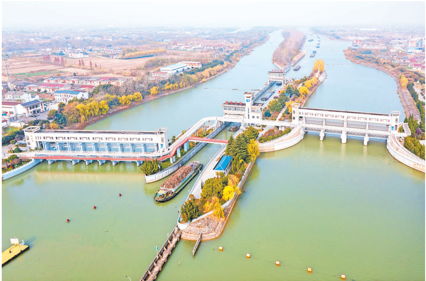
12月13日拍摄的位于江苏省扬州市江都区的南水北调东线一期工程运盐闸、邵仙套闸、邵仙闸(无人机照片)。2024年12月12日,南水北调东线一期工程迎来全面通水10周年。10年来,工程累计调水超过767亿立方米,惠及45座大中城市,受益人口超过1.85亿。新华社发
