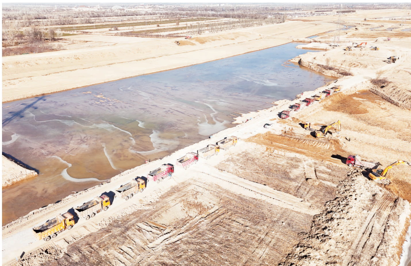
12月14日，贺兰山东麓防洪治理工程滚钟口(镇北堡)拦洪库施工现场，水利建设者斗严寒、抢工期，与190台机械配合作业进行库底清淤。项目工程2024年度建设已全面完成国债资金投资，累计完成投资15.83亿元。目前，工程已进入收尾阶段。 本报记者 裴云云 摄
