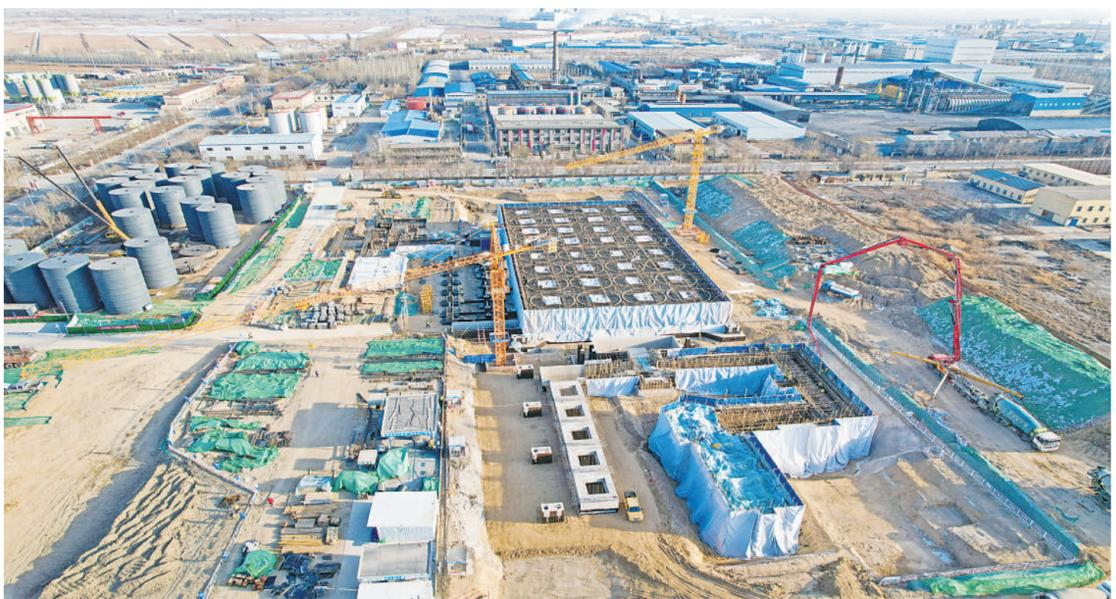
12月21日，宁夏建康新材料科技有限公司建筑新材料生产项目建设现场塔吊林立。据悉，该项目通过瞄准公路行业固废资源循环利用、废旧沥青混凝土精细分离等再生资源加工利用领域开展研发与生产，为业内提供高品质高性能的新型路面材料。预计2025年6月投产后，可年产商品混凝土30万立方米，高性能再生和原生沥青混凝土25万吨，机制砂4万吨，矿粉6000吨。
