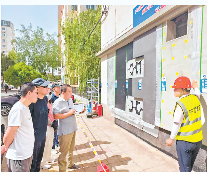
“居民监督员”与社区工作人员查看施工单位的建筑材料。(图片由受访单位提供)
