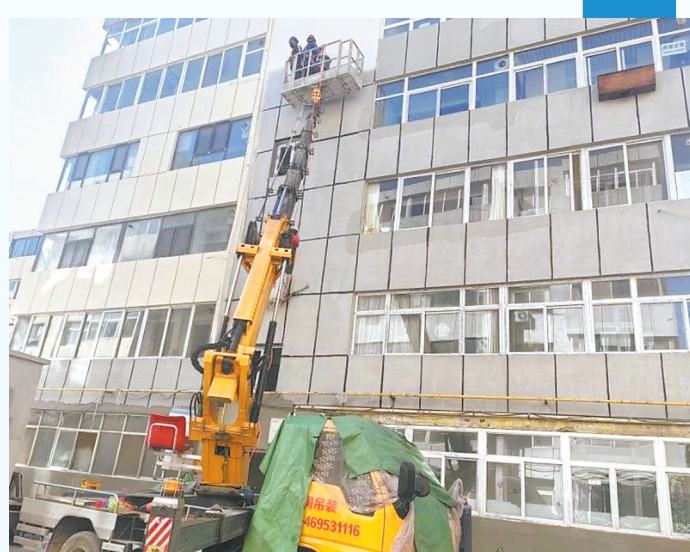
吴忠市利通区胜利镇民生小区的墙面正在翻新。(图片由受访单位提供)
