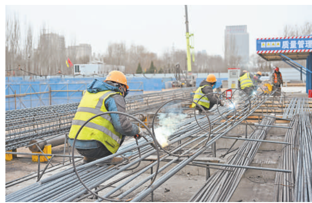
金凤区中北部排涝能力提升项目调蓄池加紧施工。
