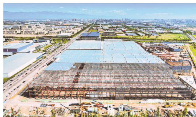
银川威力传动技术股份有限公司风电增速器智慧工厂项目建设现场。
