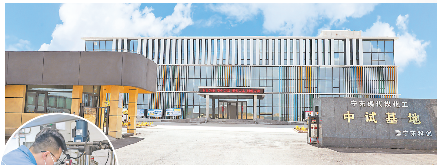
宁东现代煤化工中试基地外景。
