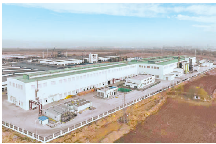
赛迈科先进材料(宁夏)有限公司厂区。
