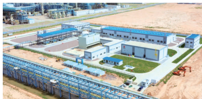
国家能源集团宁东可再生氢碳减排示范区一期项目清水管制氢厂投产。
