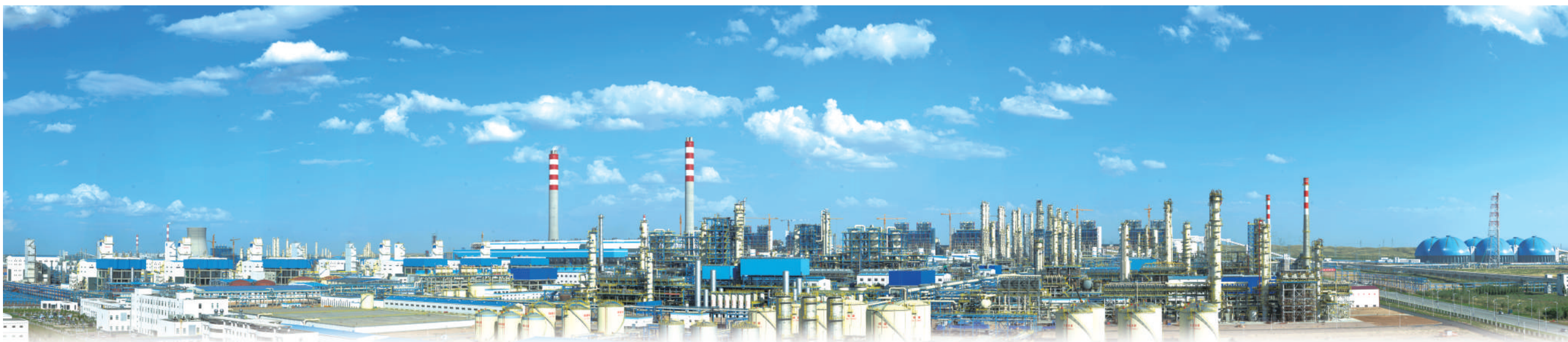
宁东能源化工基地宁夏煤业400万吨煤制油项目。宁东基地与榆林、鄂尔多斯联合共建的榆鄂宁现代煤化工产业集群入围国家级先进制造业集群。
