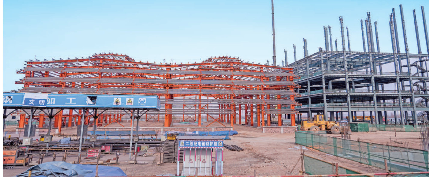
宁夏乾洋循环新材料有限公司新项目正在建设中。
