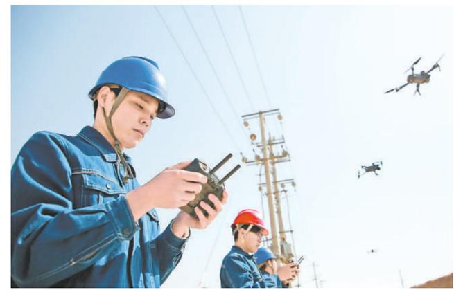
宁夏电力职工正在用无人机巡检电线路。(资料图片)
