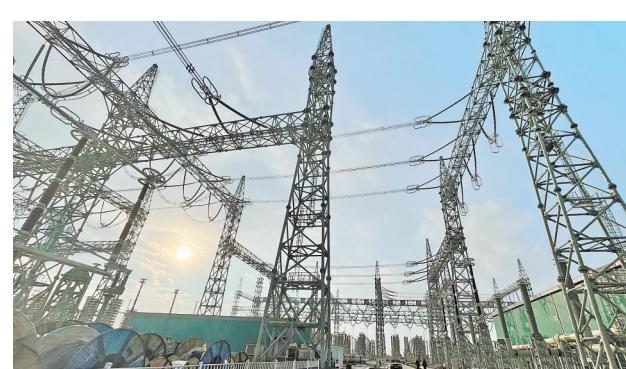
1月16日,“宁电入湘”工程中宁换流站施工现场,750千伏GIS设备完成对接安装。之后,将对其内部进行清理,抽真空、注六氟化硫气体,完成GIS耐压局放试验。预计4月30日,750千伏GIS设备完成投运。
