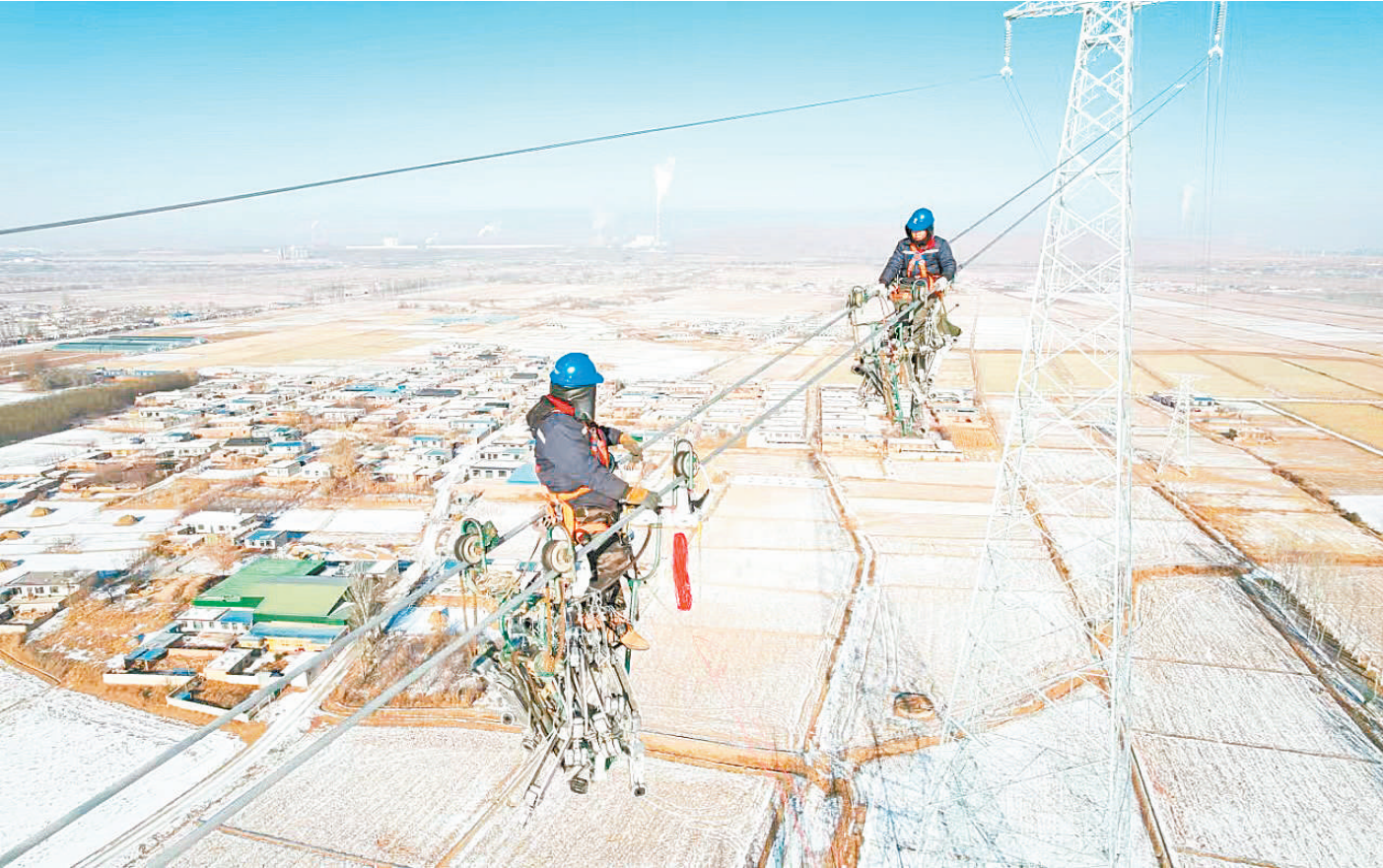
施工人员在导线上进行间隔棒安装作业。
