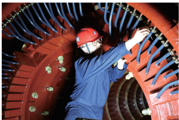
电气检修人员检修发电机。
