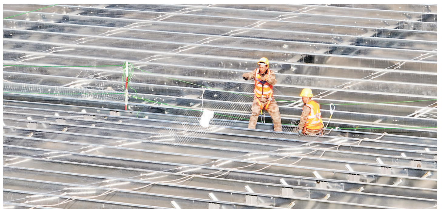
2月26日，工人在吉祥绿储200兆瓦/400兆瓦时共享储能电站项目建设现场施工。该项目位于银川市西夏区，将建设铅碳电池储能电站、220千伏变电站及外送输电线路等，预计今年5月底并网投运。 本报通讯员 袁宏彦 摄
