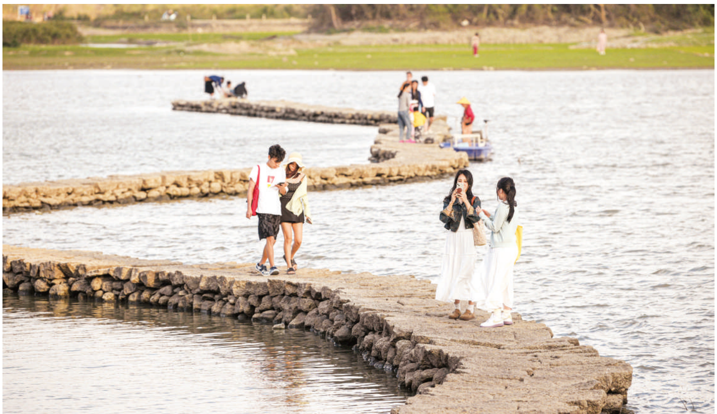
3月1日,游客在位于海口市琼山区龙塘镇的“蛇桥”游玩。国仓村石桥位于海口市琼山区龙塘镇美味河畔,是明代名臣丘濬带领当地乡绅民众修建的一系列水利工程中的一部分,距今已有500余年历史。其因形似长蛇卧伏河面,又被称为“蛇桥”。石桥由火山石修建,水深则没,水退则显,一年只在初春至初夏时节浮出水面。近期,石桥再次显现,吸引了不少游客前来踏青观景,感受当地人文历史。 新华社发
