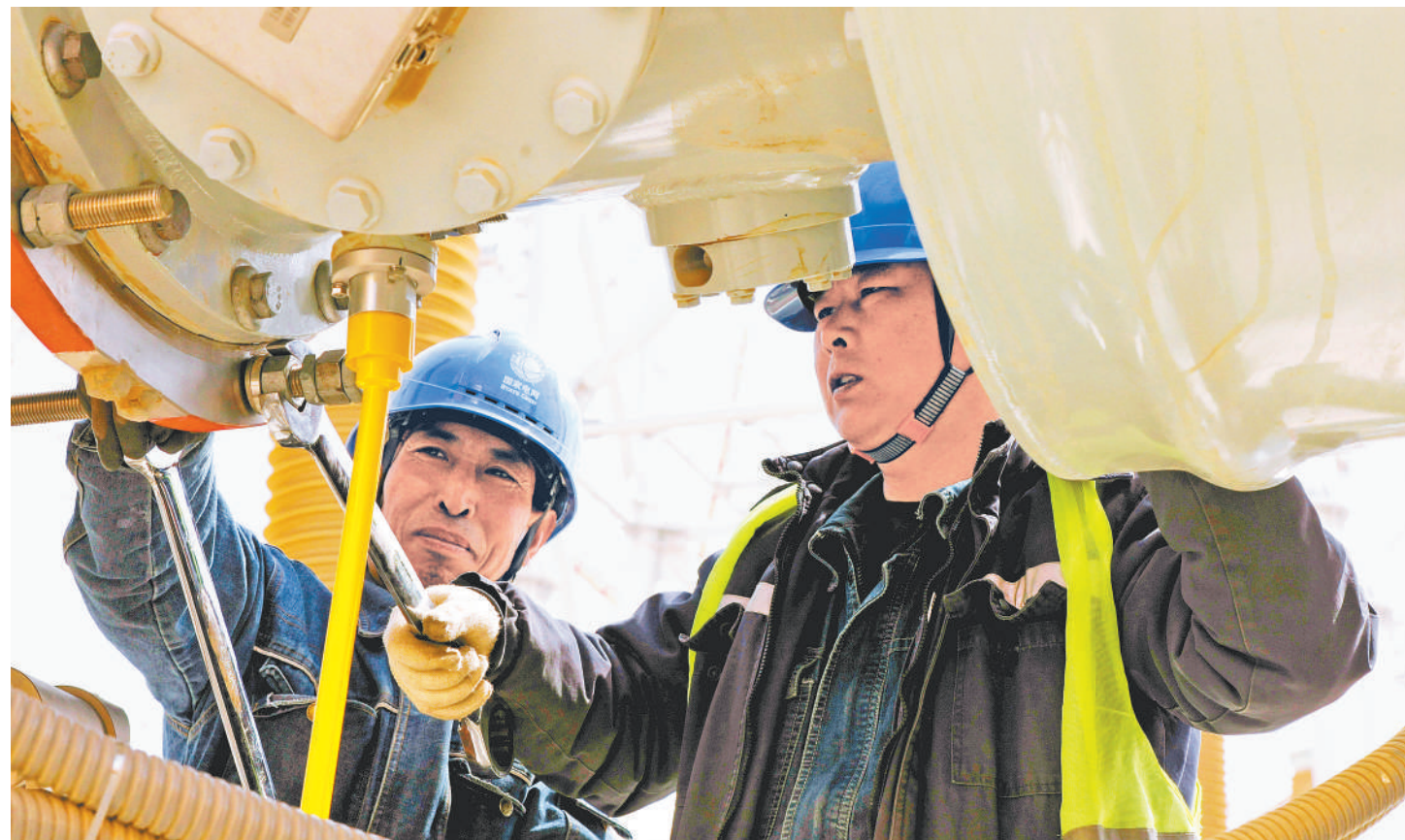
3月19日,位于同心县的妙岭750千伏变电站现场,国网宁夏电力员工正在开展春季电网检修。该站于2021年投运,带动清洁能源等重点产业投资超过300亿元。本次春季检修从3月15日开始至3月29日结束,主要进行750千伏隔离开关、高压电抗器套管更换等工作。
