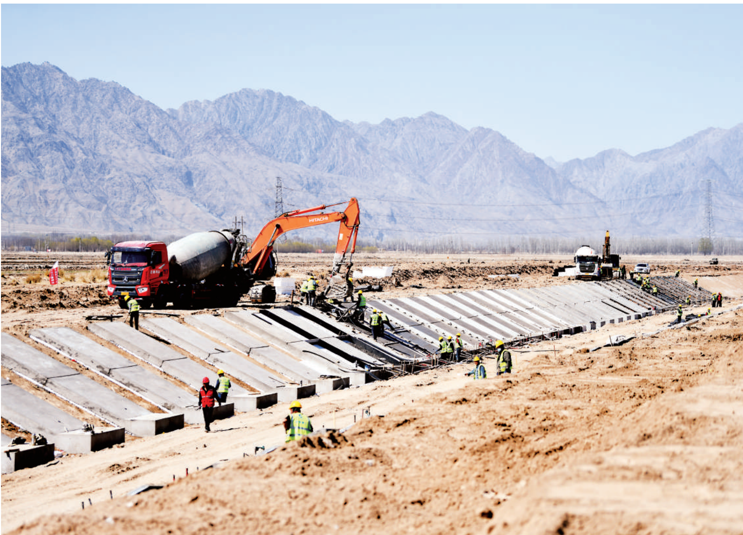
4月4日,青铜峡灌区现代化改造项目第二农场渠砌护工程现场,工人在渠道护坡上进行混凝土浇筑。据悉,4月下旬工程完工后,将显著提高水资源利用效率,保障粮食主产区灌溉用水。
