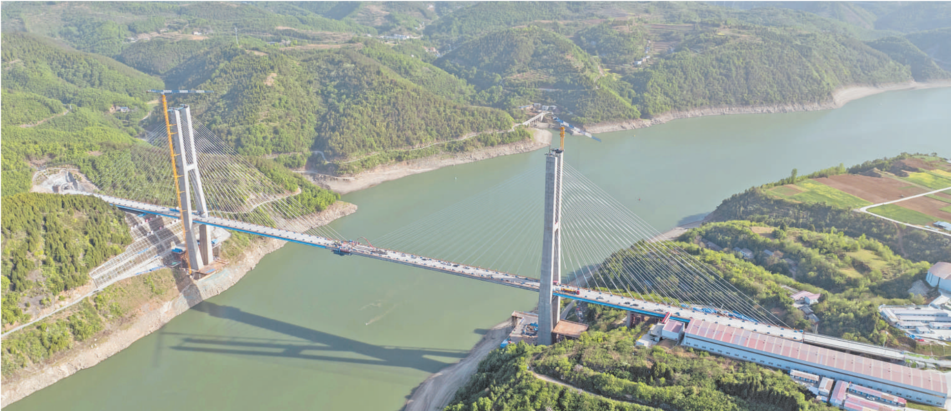
4月14日拍摄的汉江特大桥(无人机照片)。当日,由中铁十一局承建的西(安)十(堰)高铁汉江特大桥顺利合龙。汉江特大桥位于湖北省十堰市,全长917.45米,两座主塔高度达186.5米,主跨420米。
