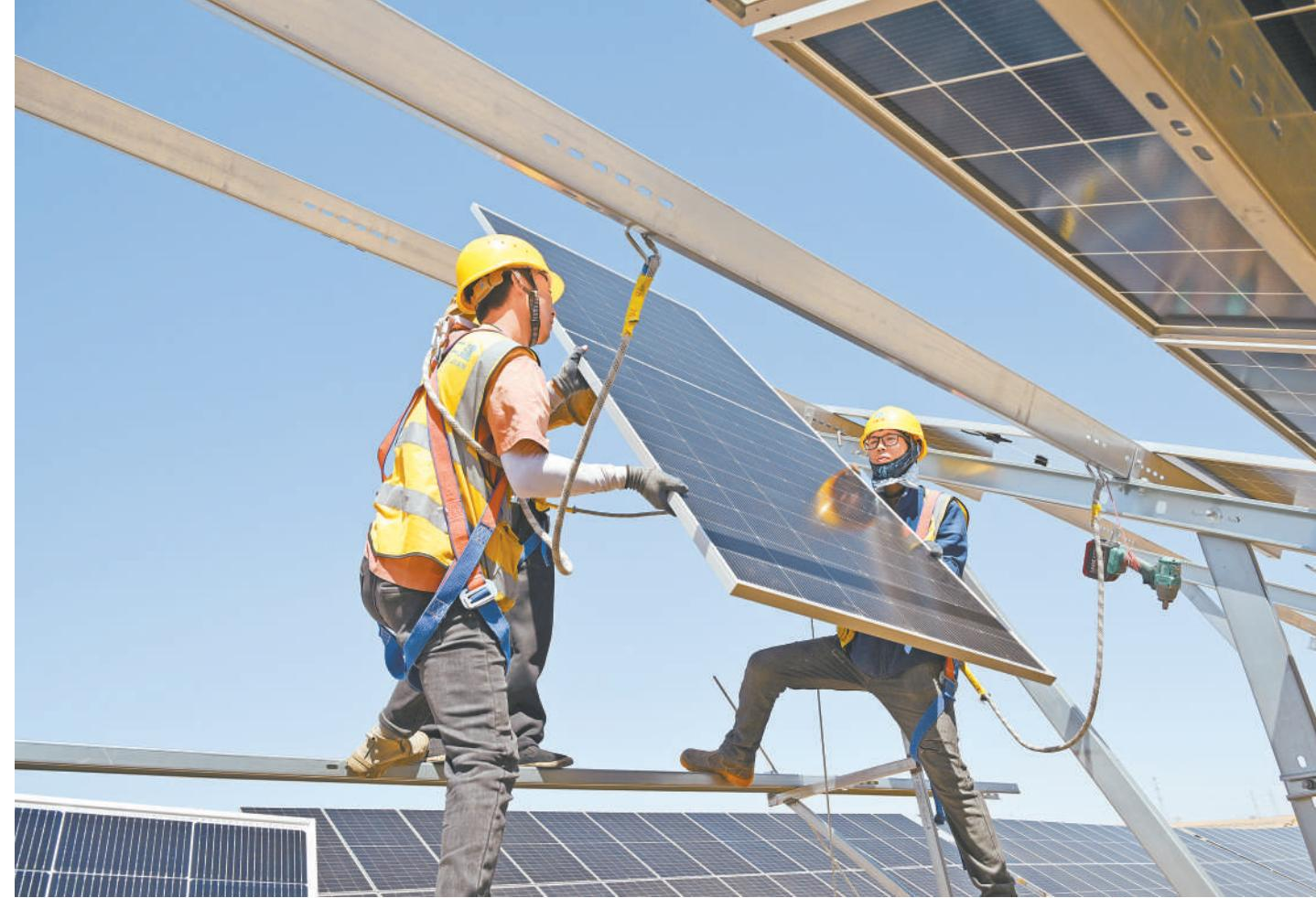
4月14日,工人在安装太阳能光伏组件。宁国运灵武100万千瓦光伏复合项目是我区规划建设的硅基绿电园区项目,项目计划总投资27.3亿元,规划建设100万千瓦光伏发电设施以及相关附属设备,新建一座330千伏变电站接入银川东750千伏变电站,主要承担银川经济技术开发区重点企业绿电替代任务,项目建成后,每年可减少55.64万吨标煤消耗,以及152.97万吨二氧化碳、108.75吨烟尘等污染物排放。
