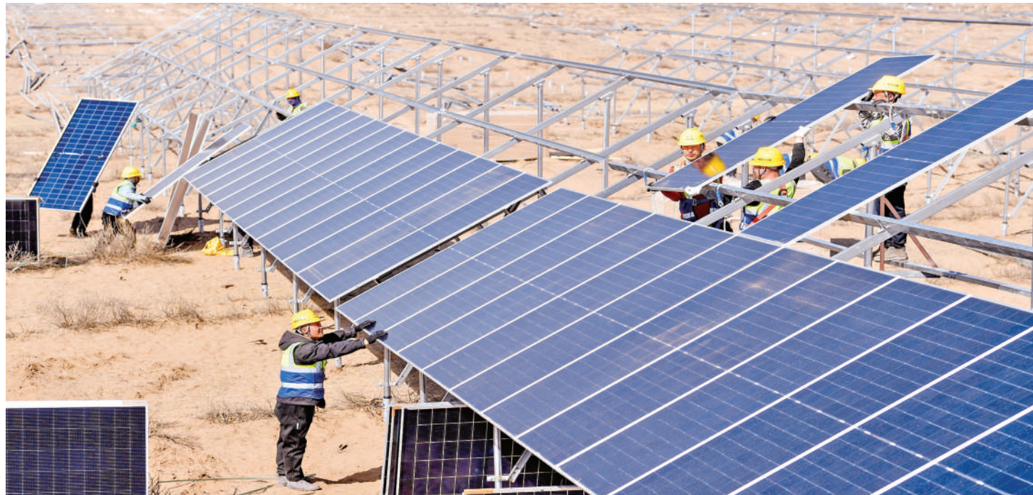
4月18日,中铁十六局集团宁国运盐池高沙窝92万千瓦光伏项目建设现场,工人在打钢桩、安支架、装组件。据了解,该项目占地2.78万亩,目前以每日完成螺旋桩施工15000根、灌注桩施工3500根、支架施工1300套的速度推进,计划6月底完成建设、具备并网条件,预计每年为电网输送超17亿千瓦时清洁电能。
