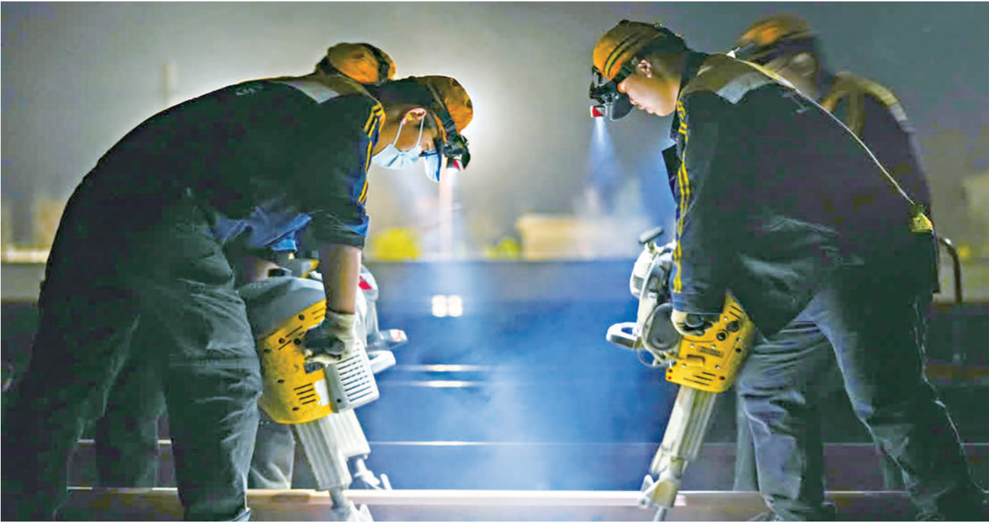
4月29日凌晨，铁路工人正在进行捣固作业，这直接关系到线路的平整度和列车运行的平稳性。
