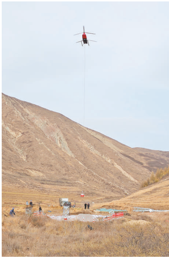
5月1日,固原将台至渝河110千伏线路工程施工现场首次利用重载无人机成功进行了电力物资运输作业,单趟运输时间从2个多小时压缩到20分钟。 本报记者 鲁延宏 摄
