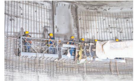
↑ 5月6日，在中储粮长沙直属库，工人在气膜粮仓内部做结构层施工。
