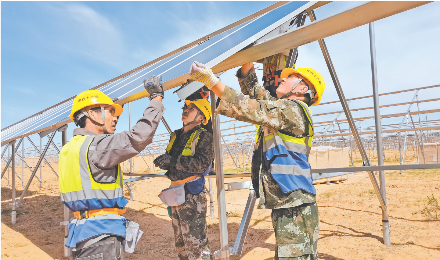
5月5日，中铁十六局集团有限公司宁夏运盐池92万千瓦光伏复合项目工地上，建设者们正在安装光伏支架和光伏组件。该项目以每日完成1600套支架的速度，向6月30日并网通电目标冲刺。
