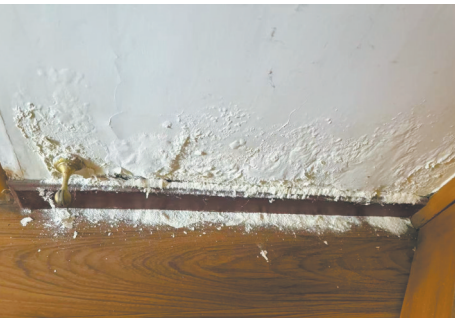
墙面被污水浸泡后起墙皮。(图片由受访者提供)
