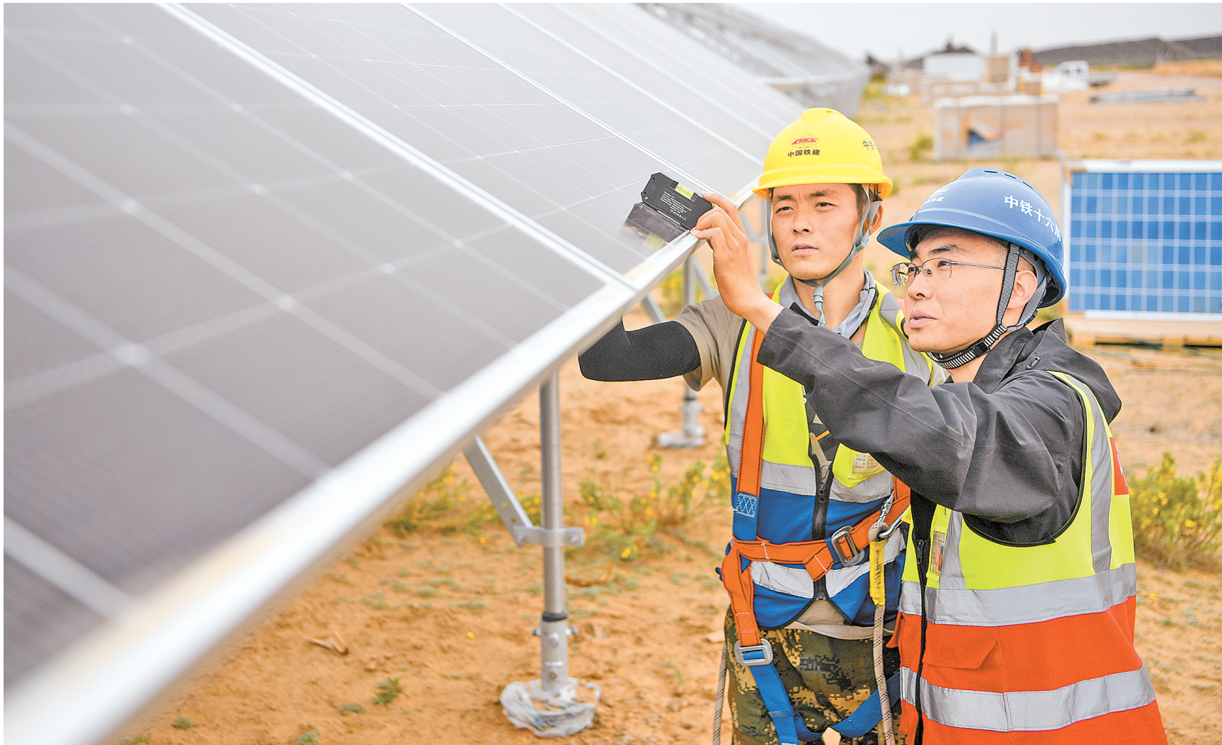
李朋立(右)在项目工地使用电子坡度仪检查光伏板安装角度。
