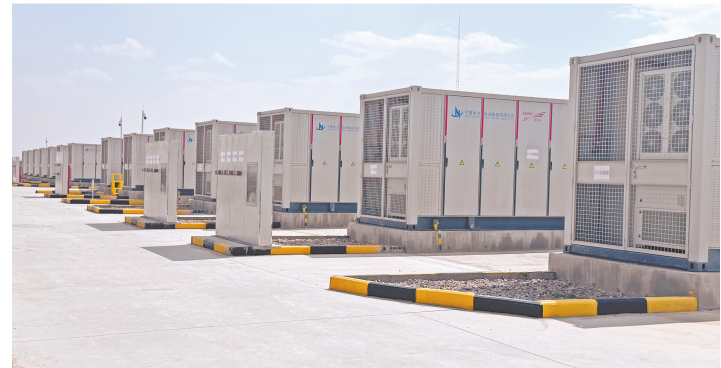
6月4日，灵武市马家滩镇的青龙山新能源共享储能电站，一个个形似集装箱的电池舱整齐排列，宛如一个个“超级充电宝”，将多余的新能源电量存储起来。截至目前，灵武市共有集中式光伏、风电新能源项目55个，备案核准总规模达1211.76万千瓦。
