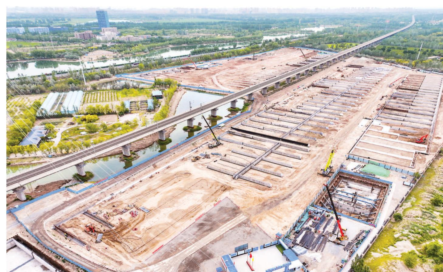
6月22日，银川市第七污水处理厂片区河湖生态再生水利用工程建设加快推进。工程建成后，第七污水处理厂一级A标准的再生水将通过湿地过滤沉淀，将水质提升至地表IV类标准，为段家湖、王家湖等8处湖泊提供生态补水，改善区域水质与环境韧性。本报记者 马楠 摄
