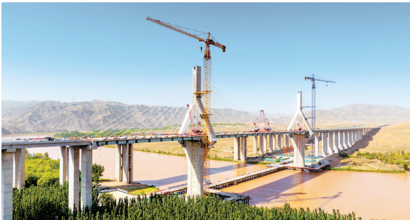
7月3日,黄河宁夏段第22座黄河公路大桥宁夏中卫黑山峡黄河大桥顺利合龙。
