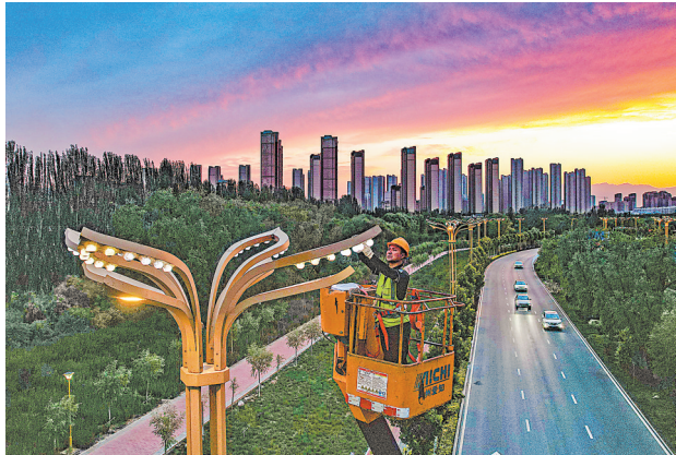
工人在维修银川市金凤五路路灯。2018年起,4万余盏高耗能钠灯陆续被替换为高效节能LED光源,节能率达75%以上,截至目前共节约1.9万度电。
