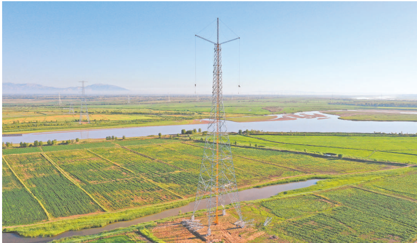
7月21日,宁夏送变电工程有限公司承建的两座电力铁塔——2066号、2067号电力铁塔顺利封顶。这两座身高135.5米、体重219.27吨的输电铁塔,是平罗电厂至沙湖Ⅰ回400千伏线路工程的控制性工程。两座铁塔的顺利组立,为8月中旬启动架线施工奠定了坚实基础。
