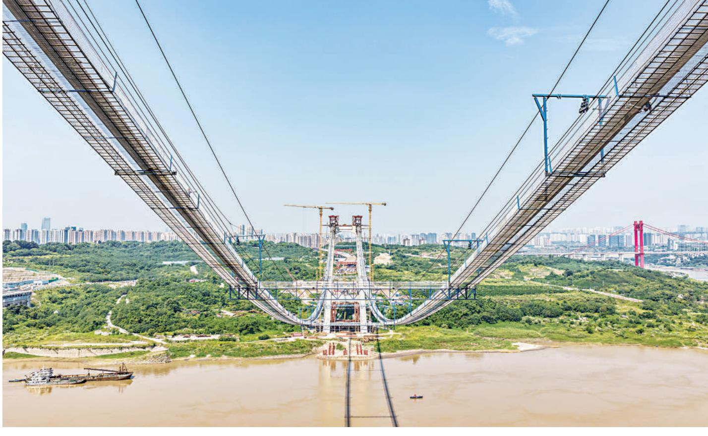
这是7月30日拍摄的重庆黄桷沱长江大桥主缆架设作业现场（无人机照片）。
