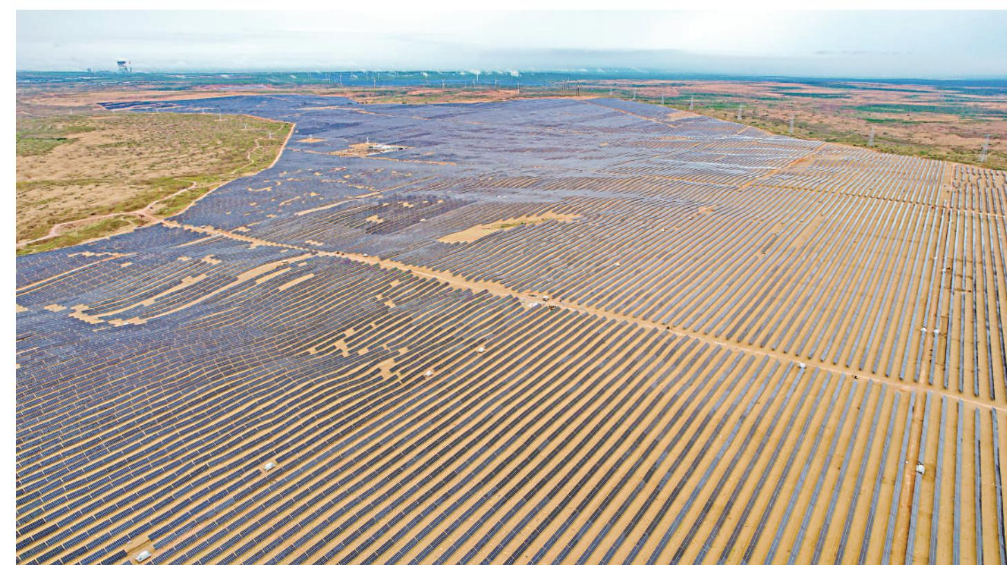
日前,自治区首批“奋力打好投资消费稳定增长攻坚战”集中采访报道组走进石嘴山市100万千瓦光伏发电复合项目现场。该项目是石嘴山市迄今最大单体光伏项目,已平稳并网运行一月有余。项目以“板上发电、板间种植、板下修复”模式实现增绿、增能、增效和降碳、降本的“三增两降”。据测算,全容量并网后,年均发电量可达19.49亿千瓦时,年节约燃煤59万吨,减少二氧化碳排放153万吨,生态效益相当于植树造林4.6万公顷。
