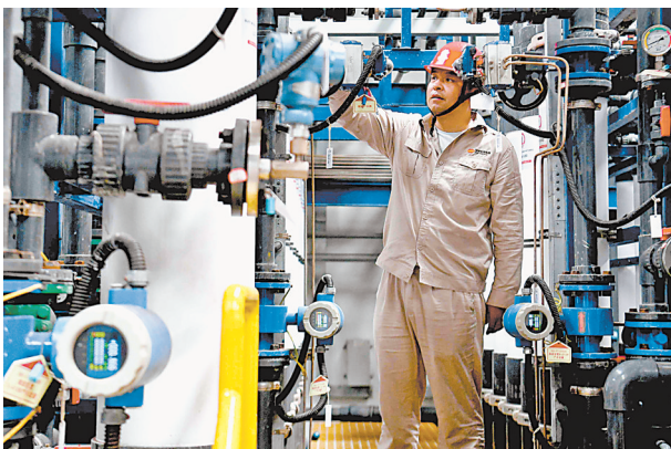
宁夏英力特化工股份有限公司氯碱和树脂分公司污水零排放技改项目,工作人员进行微滤装置设备运行状态检查。
