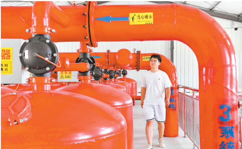
贺兰山农牧场四号泵站,员工严佳文检查过滤、配肥装置。
