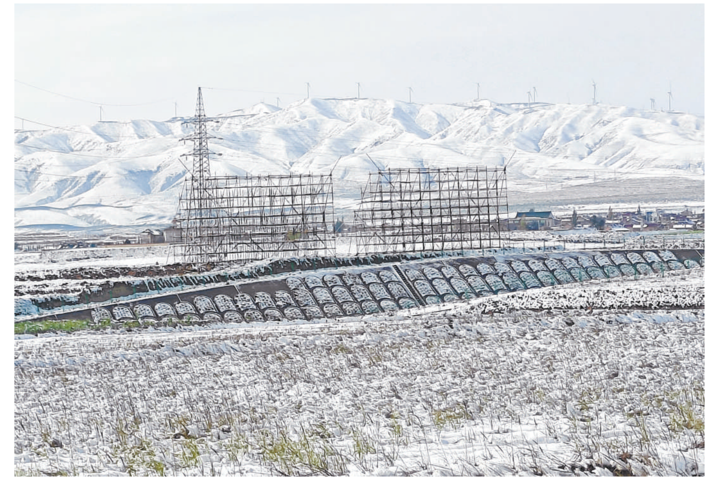
“甘电入浙”宁夏段线路工程在海平高速公路上方开展导地线跨越展放。
