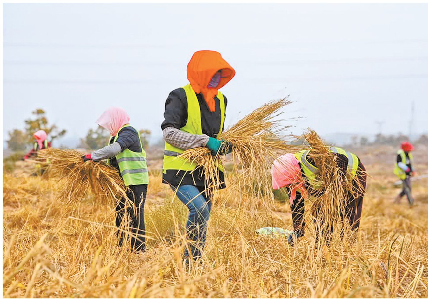
10月22日,工人在制作草方格。当日,灵武市白芨滩防风林场内机器轰鸣,工作人员采用“人工精辅+机械辅助”的作业模式治理沙地。为推进毛乌素沙地治理,银川市实施毛乌素沙地流动沙地全面固定白芨滩防风林项目,总面积8994亩,目前已完成3800亩的治理任务。按计划,11月中旬可全面完成。
