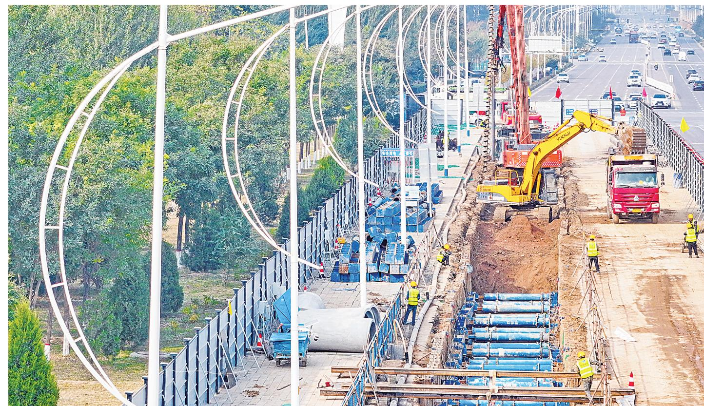
银川市兴庆区贺兰山路至大连路区域雨污分流工程一标段现场(10月25日摄)。此次改造工程是兴庆区系统性治理城市水环境、提升防洪减灾能力的关键举措,结合城市更新等重点工作,加快补齐城市排水防涝设施短板。
