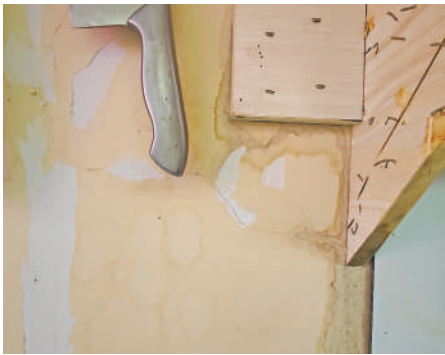
↑ 谢先生的店铺内因污水渗漏而受损严重的墙体。
