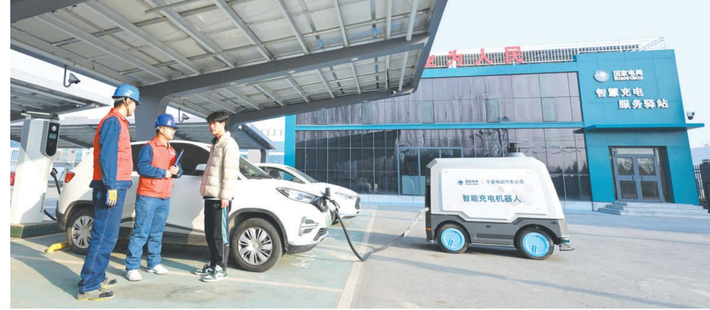
图为智能充电机器人为新能源车提供充电服务。截至11月10日，国网宁夏电力公司建设的银川南智慧充电服务示范站本年度累计充电量突破100万千瓦时，达到106.57万千瓦时。作为西北地区首个集“风、光、储、充、放”及客户服务于一体的综合性示范站点，银川南示范站依托先进技术架构，配备2兆瓦能量路由器、200千瓦峰光伏车棚、250千瓦/500千瓦峰储能系统及多套大功率充电设备，可同时满足49辆新能源车的充电需求。
