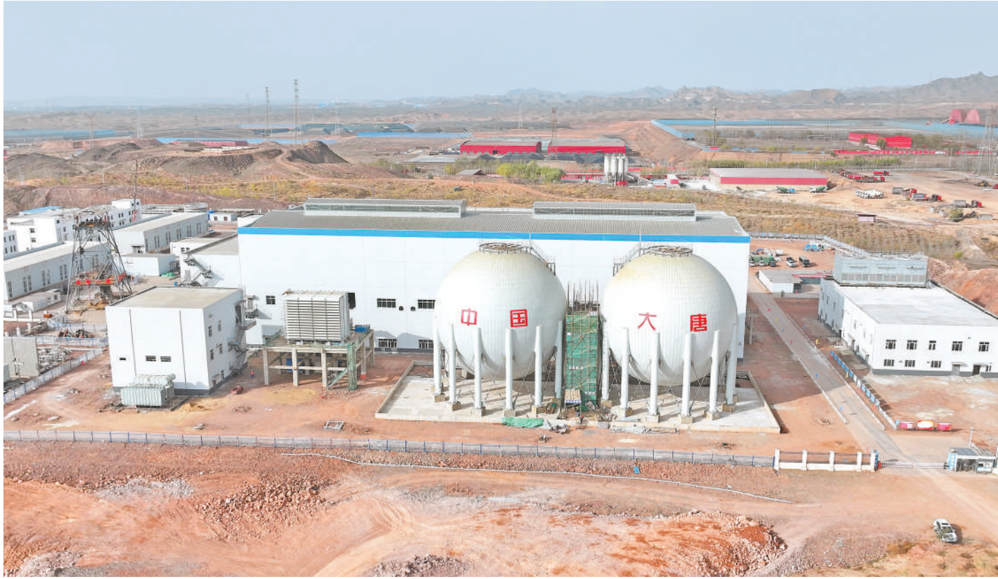
11月12日，大唐中宁100兆瓦/400兆瓦时压缩空气储能项目建设现场。作为国内首套在软岩地质条件下采用全人工硐室建设的压缩空气储能系统，该项目已成功入选国家能源领域第五批首台（套）重大技术装备名单，示范效应显著。建成投运后，预计年发电量可达1.18亿千瓦时，能满足近10万户家庭全年用电需求。
