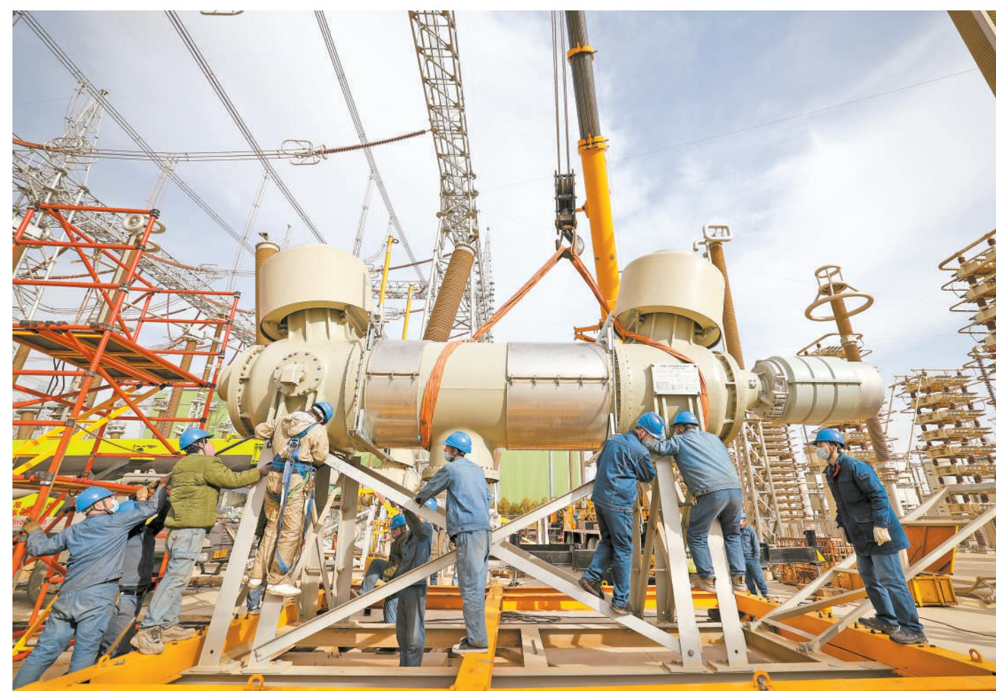
国网宁夏电力有限公司±800千伏特高压灵州换流站,检修人员正在更换交流滤波器场750千伏断路器。“十四五”期间,作为灵绍直流输电工程的送端站,±800千伏特高压灵州换流站保持平稳高效运行,已累计向浙江输送电量突破4142亿千瓦时,相当于替代标准煤超1.55亿吨。图为2022年11月17日拍摄的换流站检修人员在更换交流滤波器场750千伏断路器。
