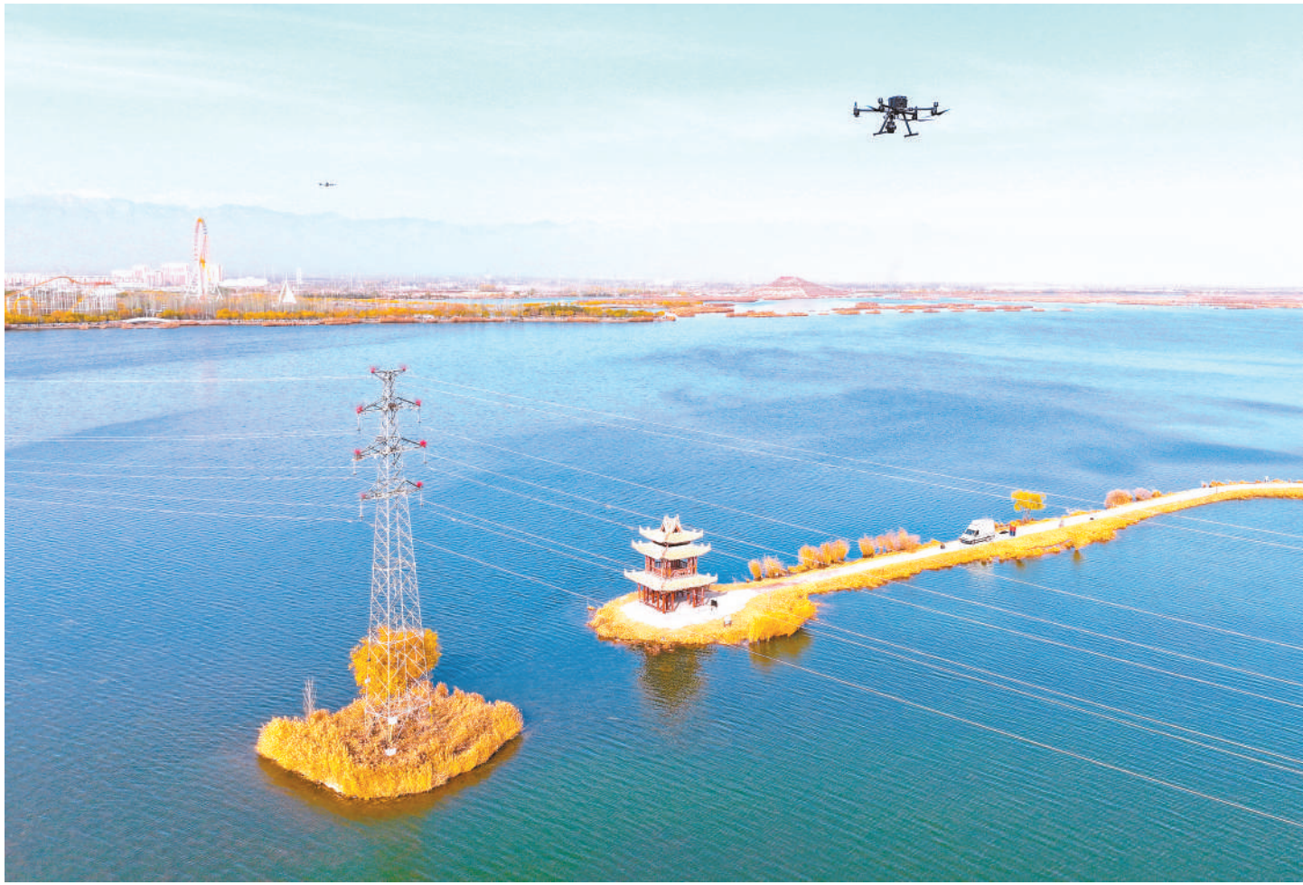
11月12日,国网银川供电公司输电运检中心员工利用智能无人机设备对110千伏“花安线”进行线路巡视。近日,国网银川供电公司输电运检中心采取“智能无人机+远程监控”等措施对所属209条线路进行立体巡视,快速精准定位和有效处置设备隐患,确保冬季电网安全稳定运行。
