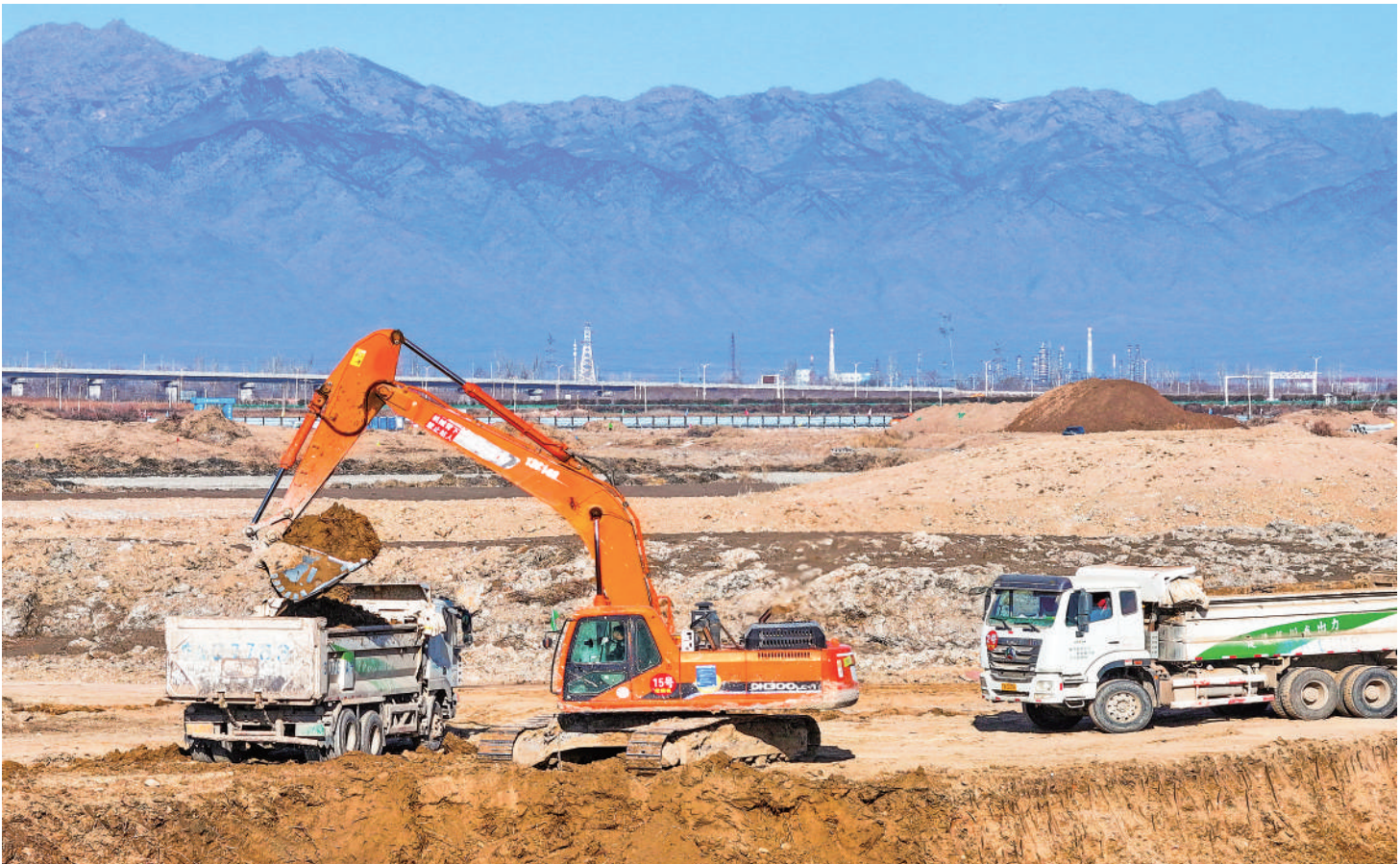
11月18日，在银川市闽海九号湖水生态修复工程四标段项目现场，工人正在有序开展湖底清淤工作。该项目自9月进场施工以来，各项工作稳步推进，12月底将完成排水、清淤、堆岛、修坡等土方作业，预计2026年9月前全部完工。届时将显著改善区域水体质量，修复退化的生态系统，提升植被覆盖率和生物多样性。 本报记者 马楠 摄
