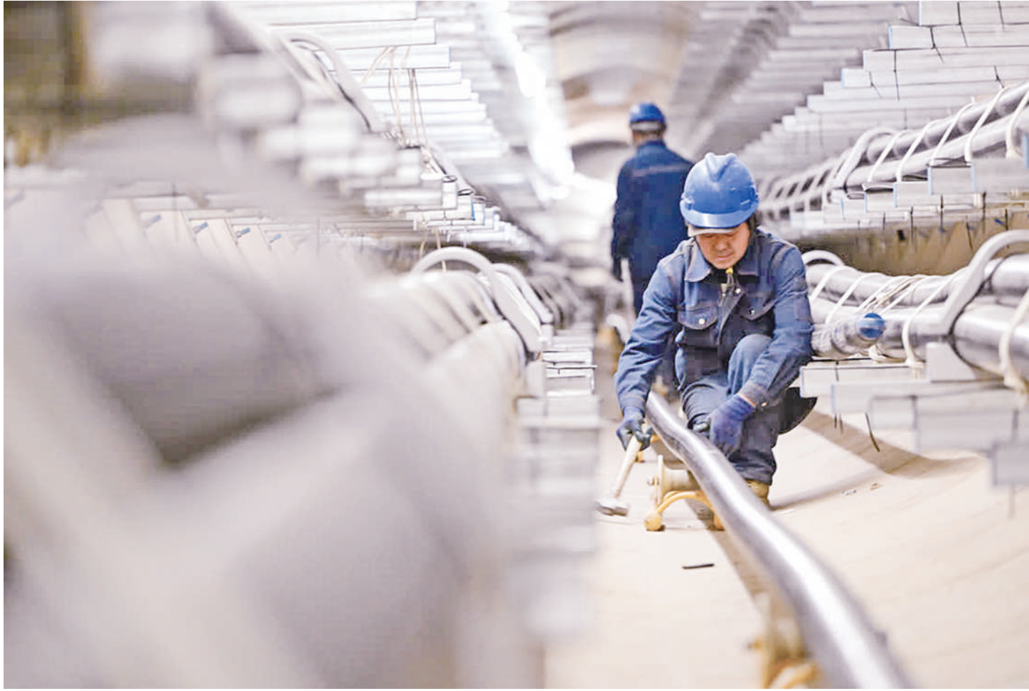
11月26日，国网银川供电公司员工在庆祥220千伏电缆工程地下隧道敷设110千伏电缆，为工程早日投运抢抓工期。庆祥220千伏输电工程由20公里电缆线路和一座全户内220千伏变电站组成，工程位于宁夏银川市金凤区长城路核心地带，是银川电网优化网架结构的关键环节，工程投运后将有效缓解银川电网迎峰度冬电力供应压力。 本报通讯员 袁宏彦 摄
