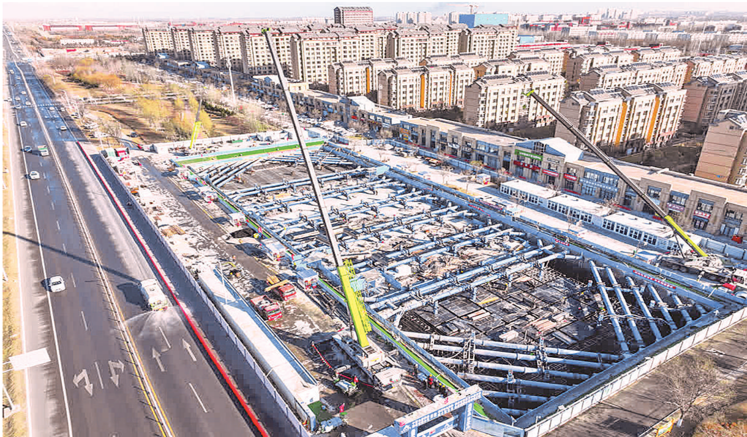
11月30日,银川市西夏区中部文萃北街调蓄水池建设工程现场,工人们在作业。该项目建成后,将提升西夏区中部排水系统的滞蓄能力,减轻雨季银川市第二污水处理厂的运行压力,筑牢城市排水安全屏障。
