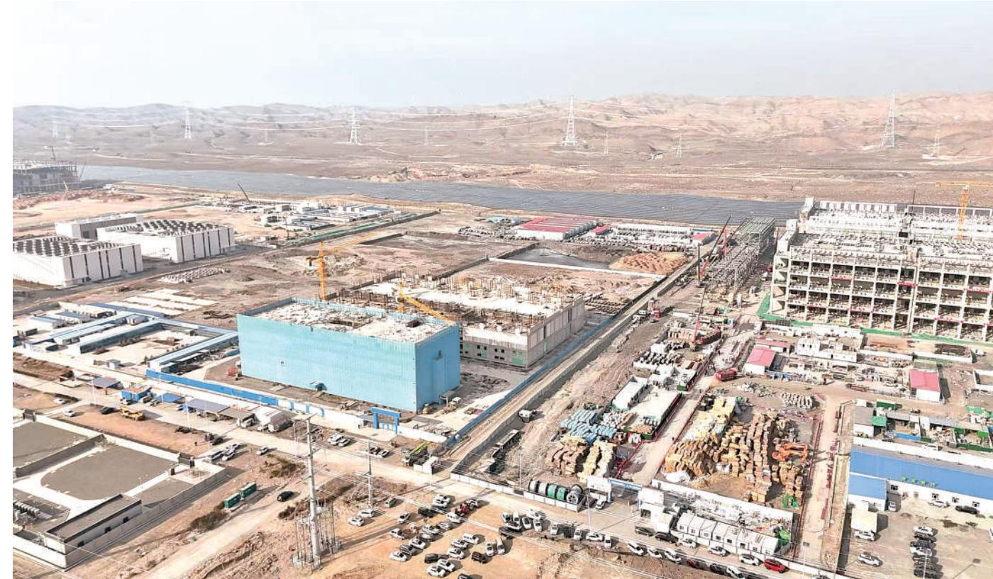
12月10日,航拍的中国联通宁夏中卫云数据中心项目施工现场。截至目前,园区内已投产5栋机房楼,2栋正在建设中,累计交付机架超8000架。项目整体投用后可承载约12万架标准机架、300兆瓦的IT负载,能提供28万GPU卡的总算力,算力规模达80EFLOPS。近年来,宁夏联通以高标准绿色数据中心为目标,致力于为大数据、人工智能等战略性新兴产业提供高效、清洁的算力服务,赋能宁夏本地数字经济发展,推动区域产业结构向高技术、高附加值方向优化升级。
